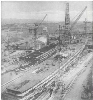
Un cantiere navale per la Marina Italiana (in primo piano) e uno per la Marina Venezolana in costruzione al Cantieri di Livorno.
