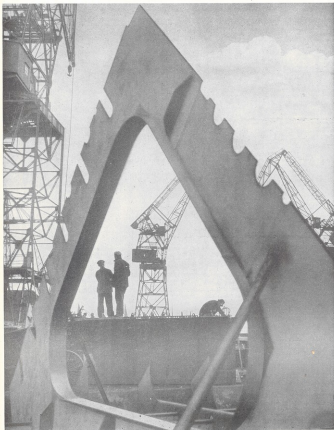
Suggestiva inquadratura di strutture prefabbricate al Cantiere del Mugello
